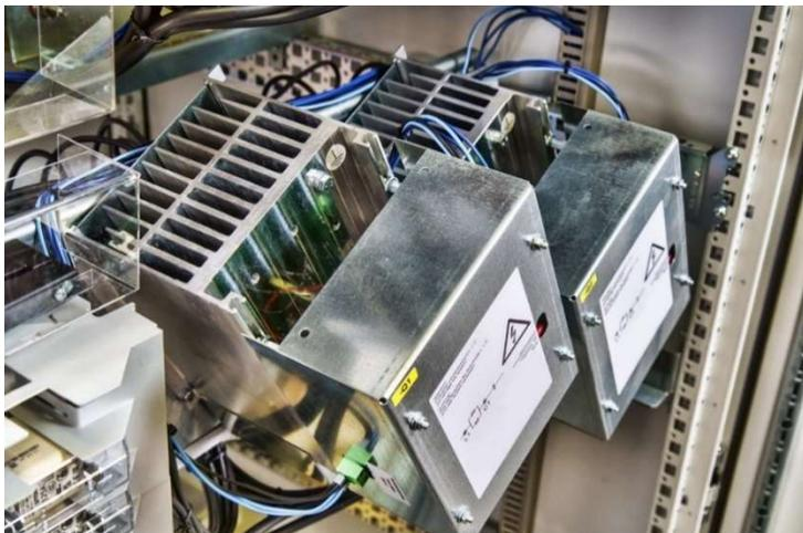
Im Vergleich zu Kondensator-Schützen ist kein Schützwechsel erforderlich. Die Schütze sind Verschleißteile und müssen spätestens nach 80.000 Schalthandlungen gewechselt werden. Bei hoher Schalthäufigkeit kann dies schon nach 2-3 Jahren sein. Dank dieser integrierten Schaltertechnik mit Thyristorschaltern lassen sich die Module reibungslos und verschleißfrei ein- und ausschalten. (siehe Bild 2.).
